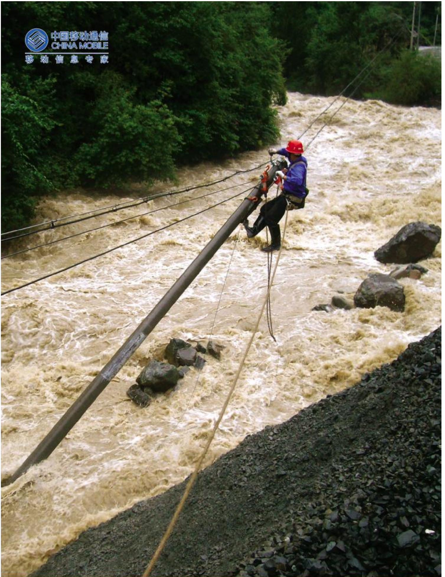
2010年7月15日-7月17日，雅安市普降特大暴雨，造成严重的洪涝灾害。中国移动四川雅安分公司在抗洪救灾中全力保障通信畅通，图为公司维护人员在抢修光缆。
