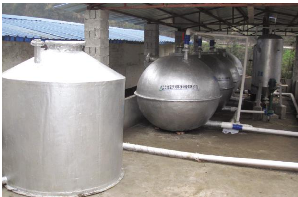
餐厨垃圾处理设备
