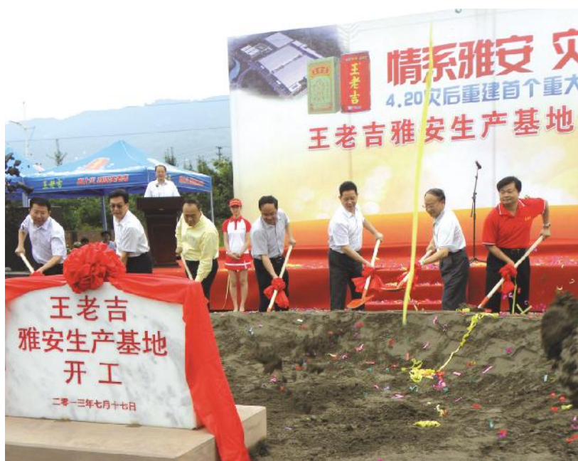
市领导和嘉宾共同为项目开工培土奠基
