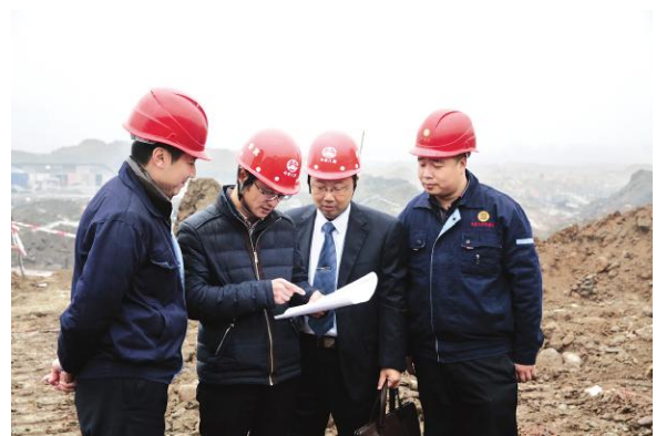
法律顾问与工程管理人员在中国恒天汽车项目施工现场研究如何解决影响施工进度问题。
