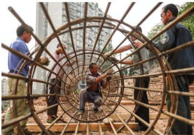
北二路附近，工人正在捆绑高架桥的桥墩钢架
