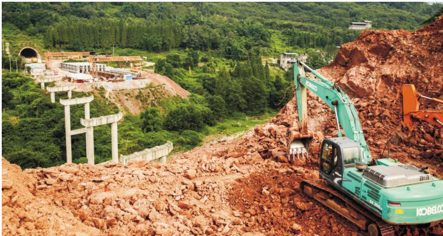
青鼻山隧道外，已经浇筑好的北外环线桥墩
