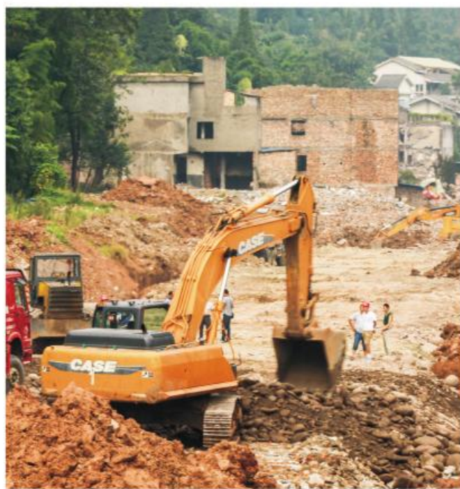
沙湾先锋路附近，正抓紧施工
