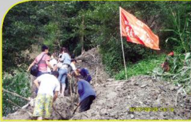
宝兴县五龙乡东升村党员突击队抢修东升村至东风村的便道
